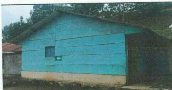
Foto 6: Vista de aula en donde se necesita rehabilitar la pared para continuar con los cimientos de concreto.
